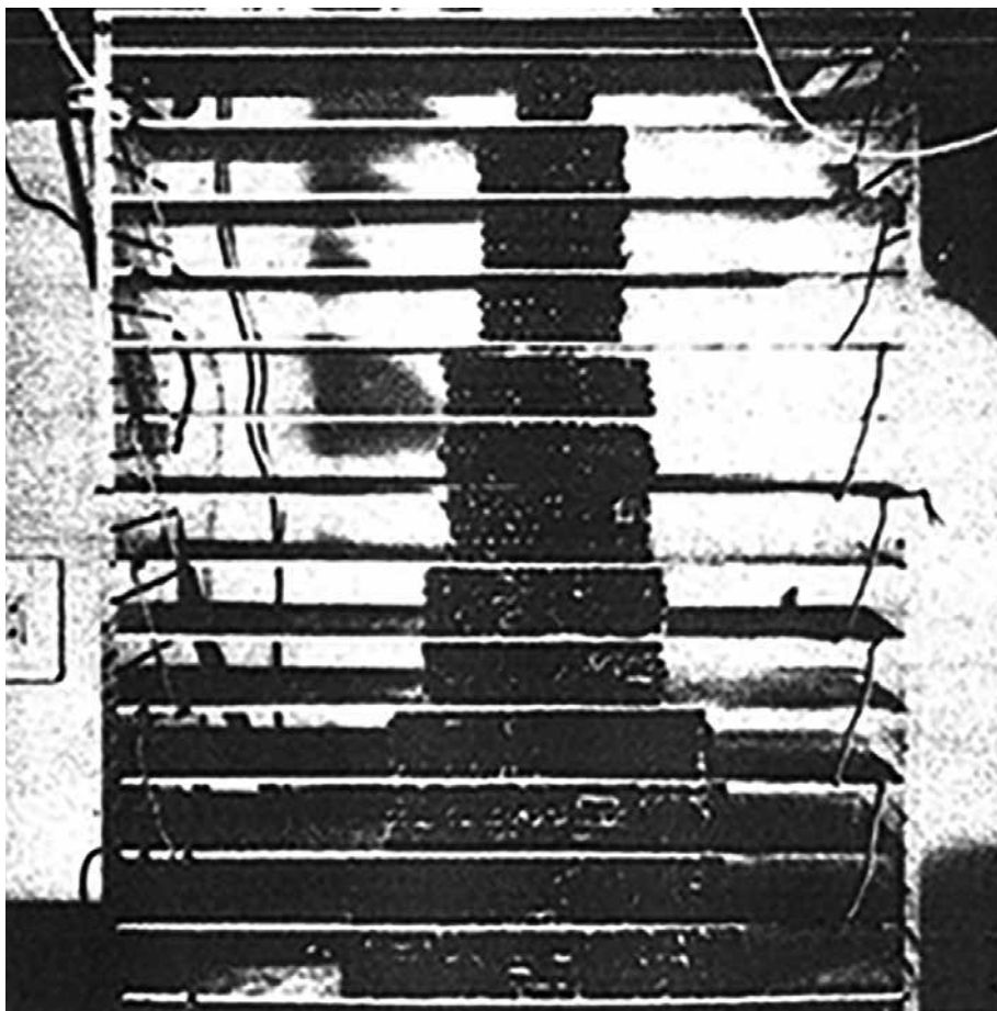
Figura 3. Foto della prima camera odoscopica costruita a Pisa.
