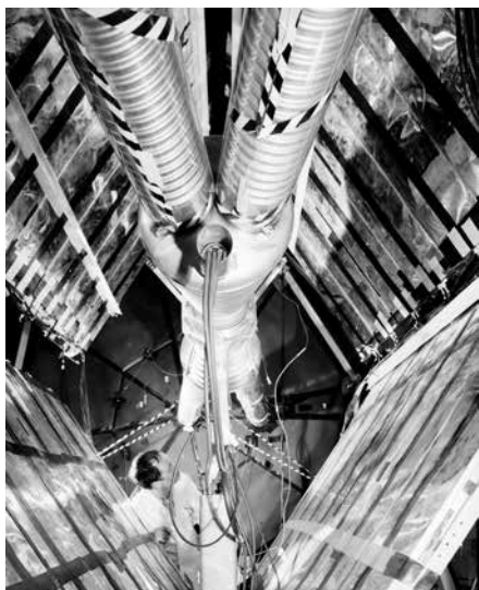
Figura 11. Nella foto si vedono i due tubi a vuoto ed il bicono di R801. Anche per R209 verranno installati nella zona di Intersezione I2 dei tubi a vuoto ed un bicono identici a quelli di R801.
